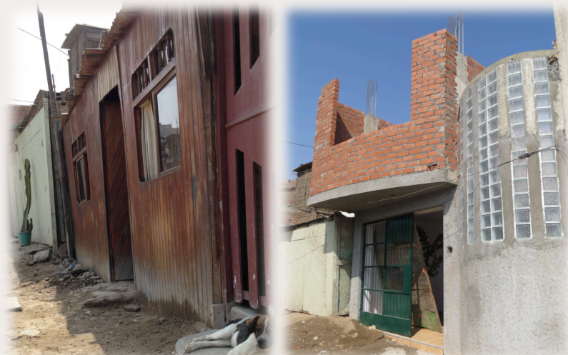
Haus Estacion Esperanza vorher (Juni 15) und nun nachher (November 15)
