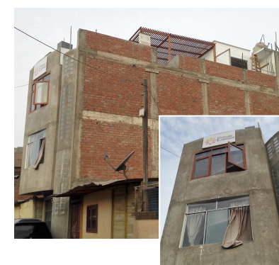
Das Haus Estación Esperanza ist fertig gebaut (Fassade Ventanilla-Stil)
