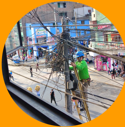
Reparatur von Elektrizität
