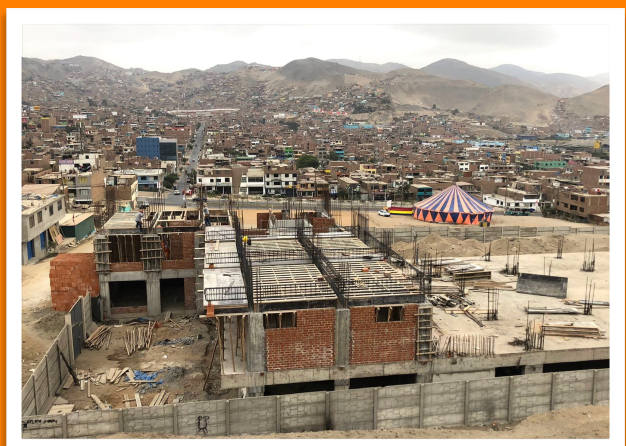
Fortschritte beim Bau (Kindergarten)
