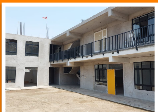
Kindergarten: Türen und Fenster einbauen
